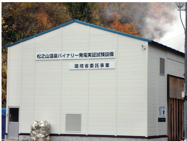
図3 松之山温泉バイナリー発電実証実験設備
