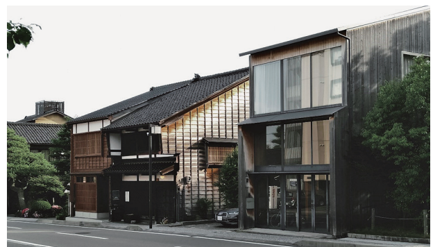
写真8 金沢：都市美文化賞の街並み（右端の新築及び右から2軒目の町屋修復が2016年度に受賞。左端は料亭、左から2軒目はリニューアル住宅。寺町付近）
